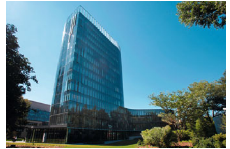
Die Westarkade der KfW in Frankfurt am Main: eines der energieeffizientesten Bürohäuser weltweit
