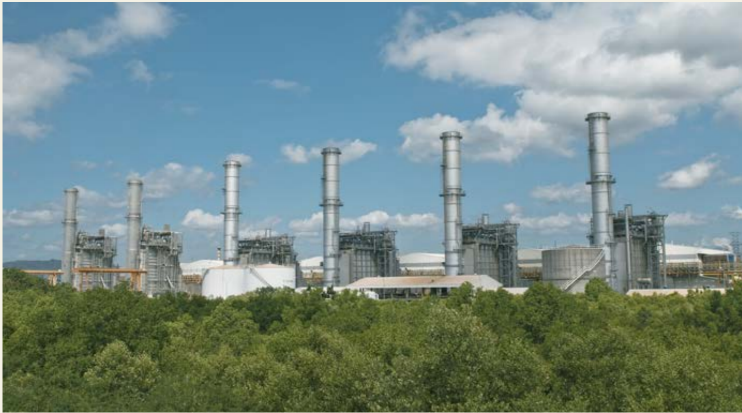
Über 60% Wirkungsgrad, geringe CO 2 -Emission, hohe Betriebsflexibilität: Mit San Gabriel auf den Philippinen finanziert die KfW IPEX-Bank das effizienteste Gas-und-Dampf-Kraftwerk Südostasiens.
